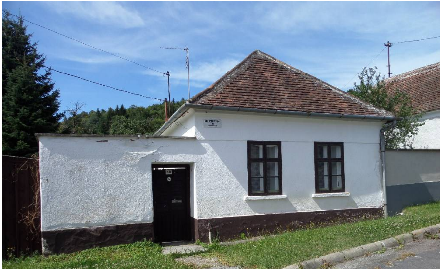
Rákóczi utca 55 (96 hrsz-ú) lakóház
