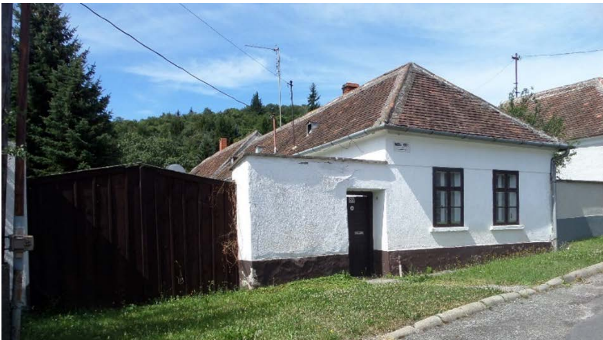
Eredeti állapotban fennmaradt fésűs beépítésű porta
